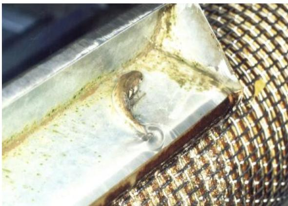
Eine vor dem Rechen von einer Schöpftasche erfasste und auf den oberem Umkehrpunkt des Rechenbandes transportierte Forelle wird in die unten befindliche wassergespülte Rinne geschüttet und zum Untergraben der Wasserkraftanlage gespült.
