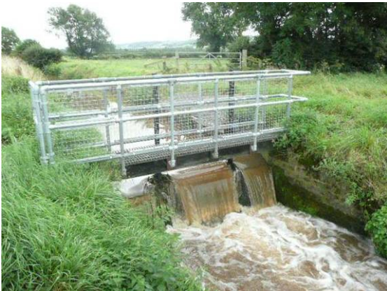
G. Stop log weir
