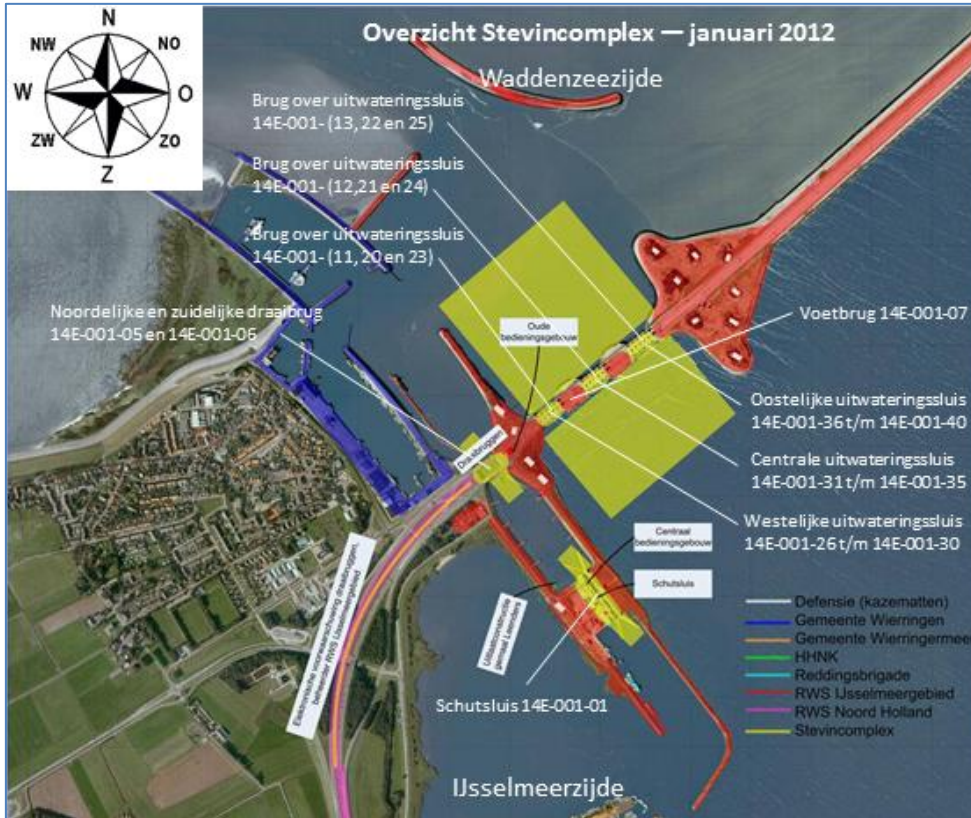
Figuur 8 Bovenaanzicht Stevincomplex Den Oever (januari 2012)
